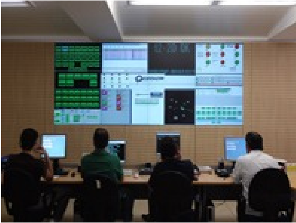
La sala controllo.
